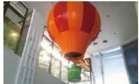
FRP等造形 製作・施工
