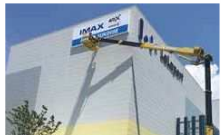
屋外看板 製作・施工
