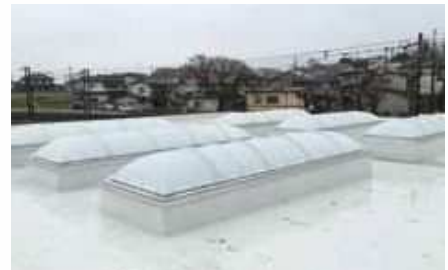
採光ドーム 製作・施工
